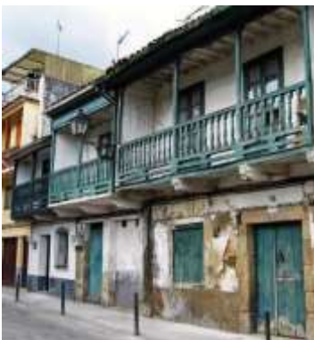
Rua da Cañota. Vivendas fronte o solar.
