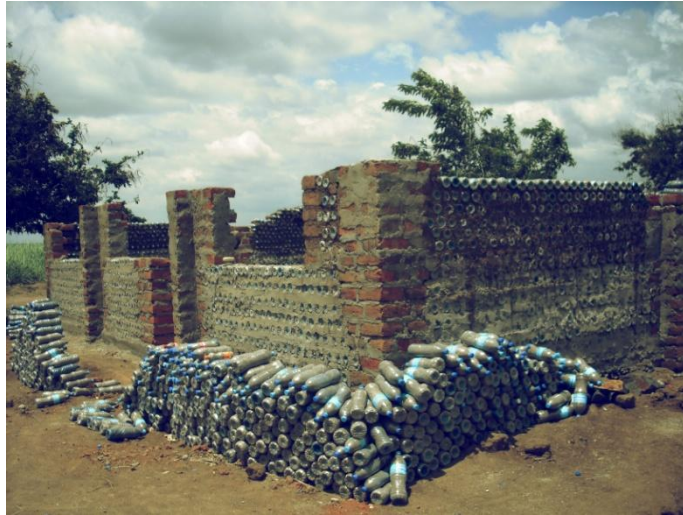
Construcción de la casa del guarda
