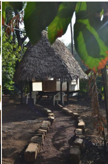
Vista exterior de la cabaña
