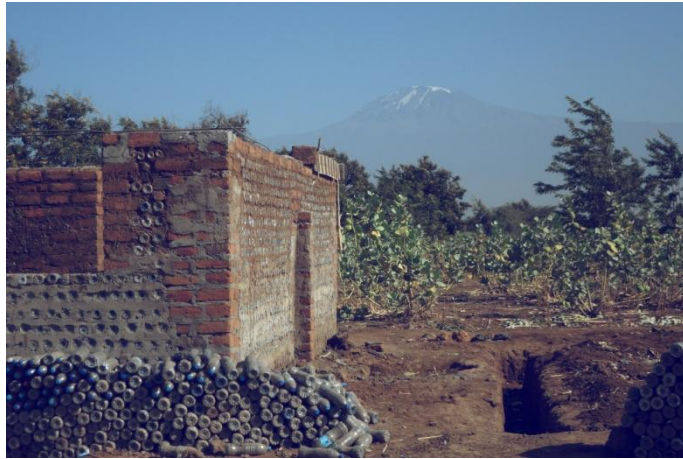
Construcción de la casa del guarda con el Kilimanjaro de fondo
