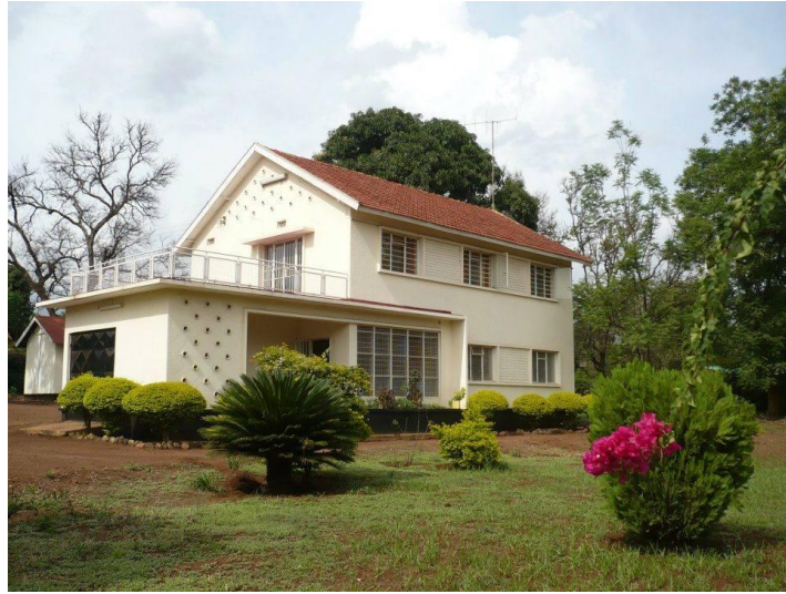
Vista exterior del Karibu Hostel
